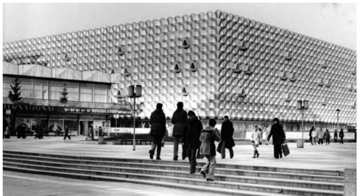
Viergeschossiger Kompaktbau, 1978, mit vorgehangener Aluminiumfassade und zurückgesetztem Schaufensterbereich, 10.800 m<sup>2</sup> Verkaufsfläche, monolithische Stahlbetonskelettbauweise, 25 Meter Höhe. Um einige Stufen höher ist der nördliche Teil der Prager Straße mit dem „Solitär“ CENTRUM angelegt.
